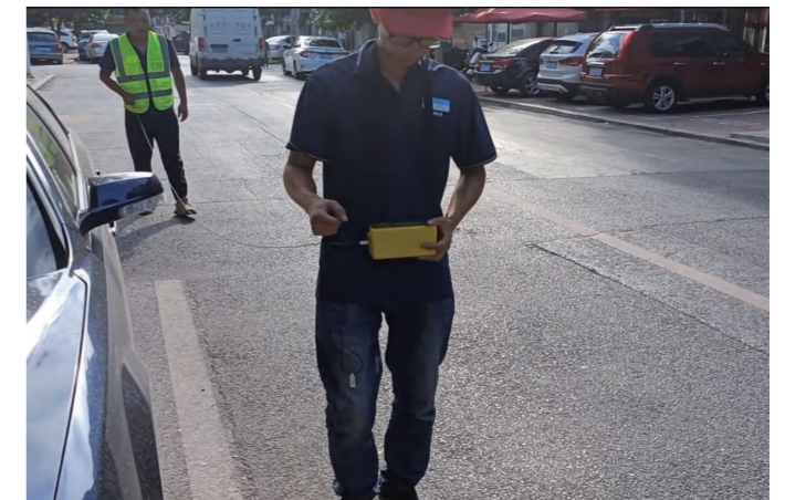
使用防腐层破损检测对地理热力管道测漏
