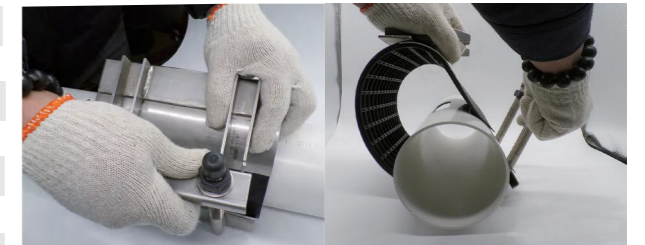
步骤2：将板式修补器环绕到管道上，注意漏点位置避开胶板重叠处最佳
