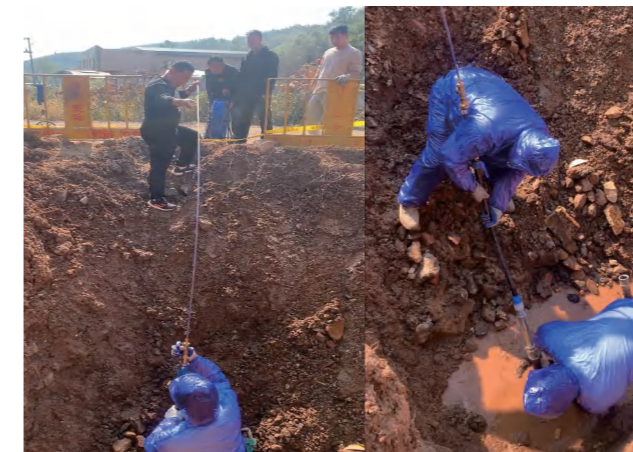
使用管道内置听漏仪对漏点进行精确定位
