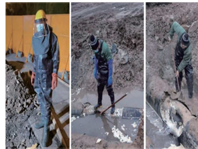
热力管道抢修现场，穿戴气凝胶隔热服进行作业，可耐高温防止烫伤
