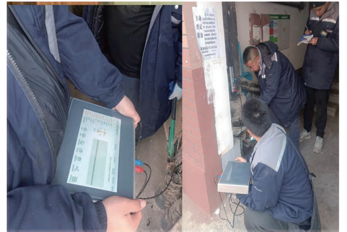
在小区使用二网平衡调节仪对楼道阀门流量进行调节
