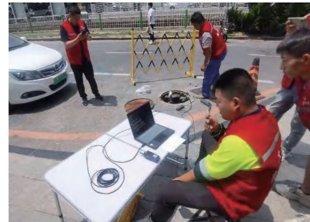
大连万达广场商业街马路给一地下管段做管网腐蚀检测
