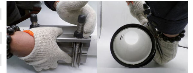
步骤3：将两盖板拉紧重叠后，拧紧螺母
